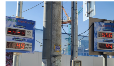
미세먼지, 유해물질 현황판 설치
