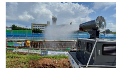
고압 살수장치 활용
