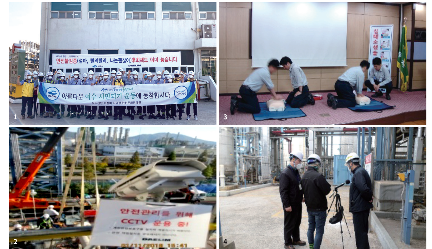
1 신증설 및 정기보수 안전 캠페인 2 이동용 CCTV를 활용한 작업 안전관리
