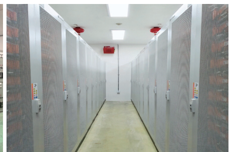
전주공장 에너지저장시스템(ESS) 운영
