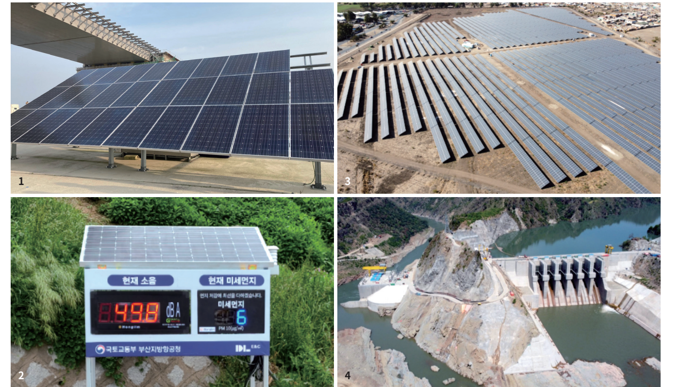
1 새만금 남북도로 3공구에 설치된 태양광 발전시설 2 울릉공항 현장에서 운영 중인 솔라에너지 소음·미세먼지 측정기기 3 칠레 PMGD SOL DE SEPTIEMBRE 태양광 발전시설 전경(2020년 7월 준공) 4 파키스탄 Gulpur 수력발전시설 전경(2020년 3월 준공)
